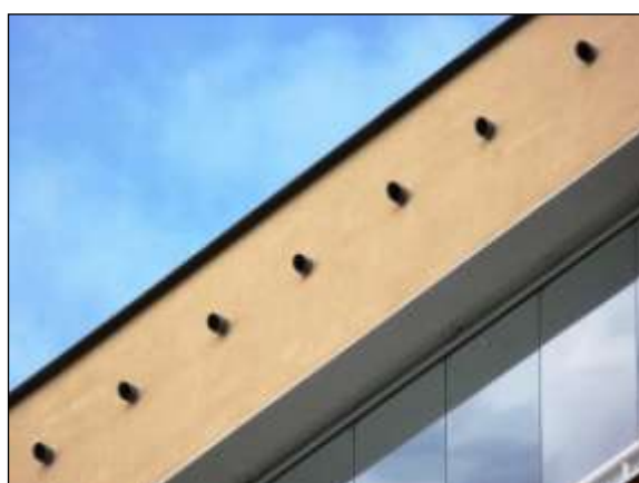
Ukázka nesprávného provedení opatření, trubky vyčnívají spodními okraji ze zateplené fasády a jsou pro rorýse jen obtížně překonatelnou překážkou
